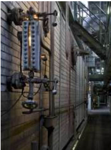
Die einzige Möglichkeit, das Kesselwasser zu sehen: hinter dickem Glas im direkten Wasserstandanzeiger. Foto © Eberhard Lantz
