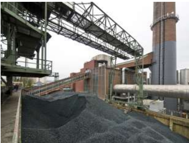
Kohlenlager vor dem Kesselhaus des städtischen Kraftwerks Bielefeld
