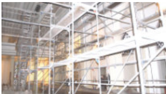
Gerüst im Kirchenraum
