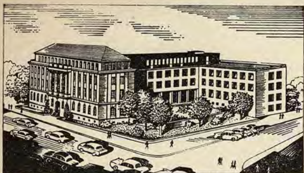
Das derzeitige Verwaltungsgebäude der Landeskreditanstalt am Schiffgraben in Hannover
