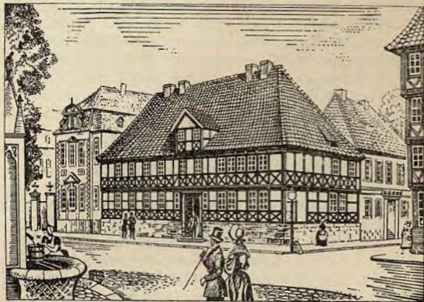
Das alte Verwaltungsgebäude der Creditanstalt am Archiv in Hannover
