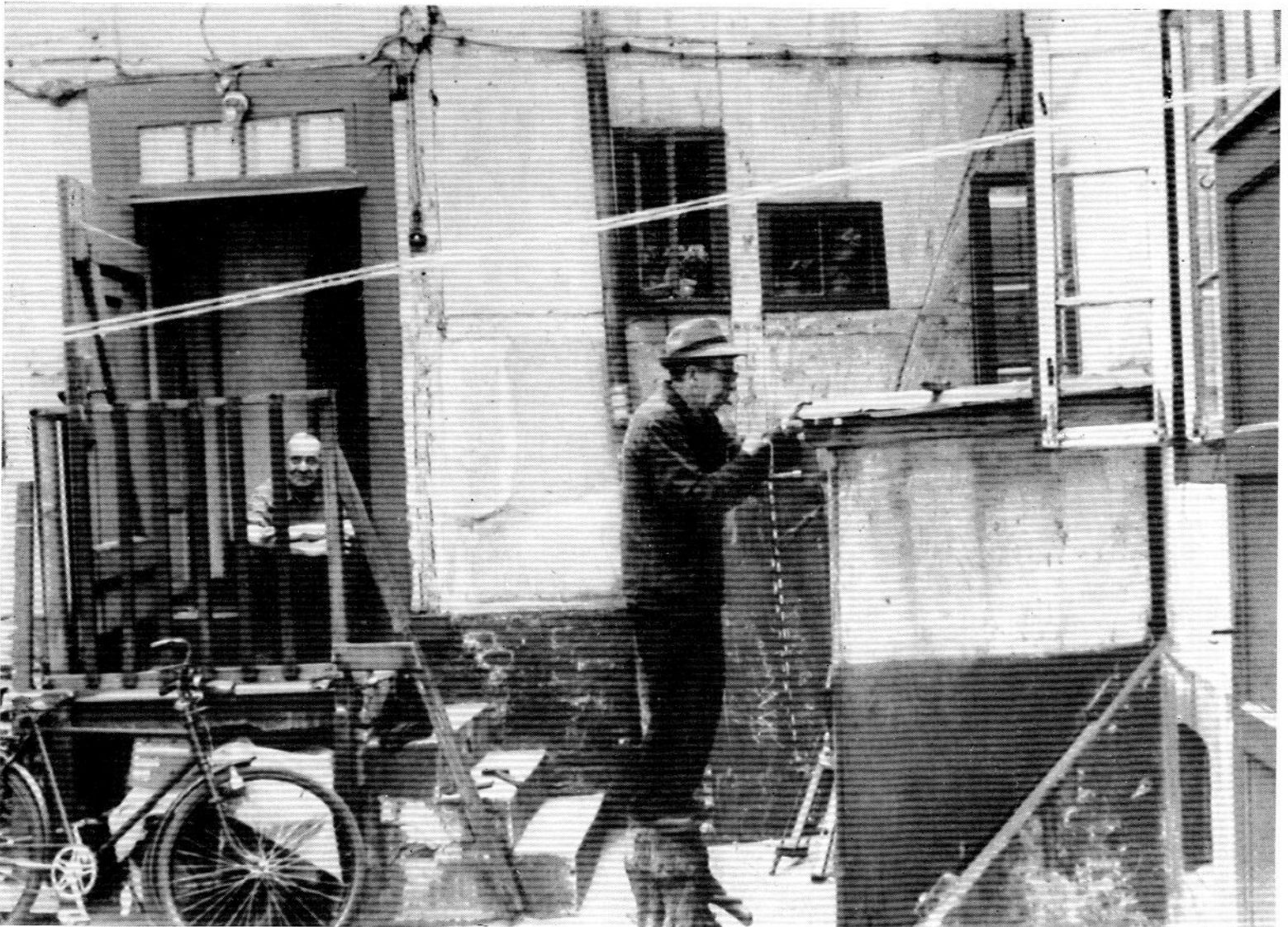
Bild 20: Hinterhof Charlottenstraße 31. Die Aborttür wird festgeschraubt.
