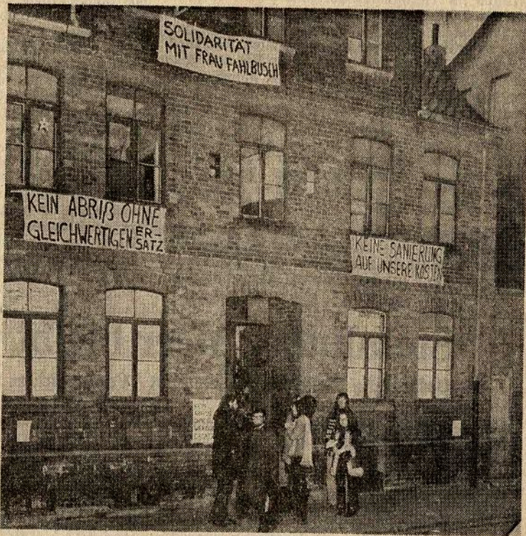
Mit Spruchbändern an der Fassade des besetzten Hauses in der Charlottenstraße artikuliert die „Aktion Wohnungsnot“ ihre Bedenken gegen die Sanierungspolitik. Aufn. (2): Kleindienst
