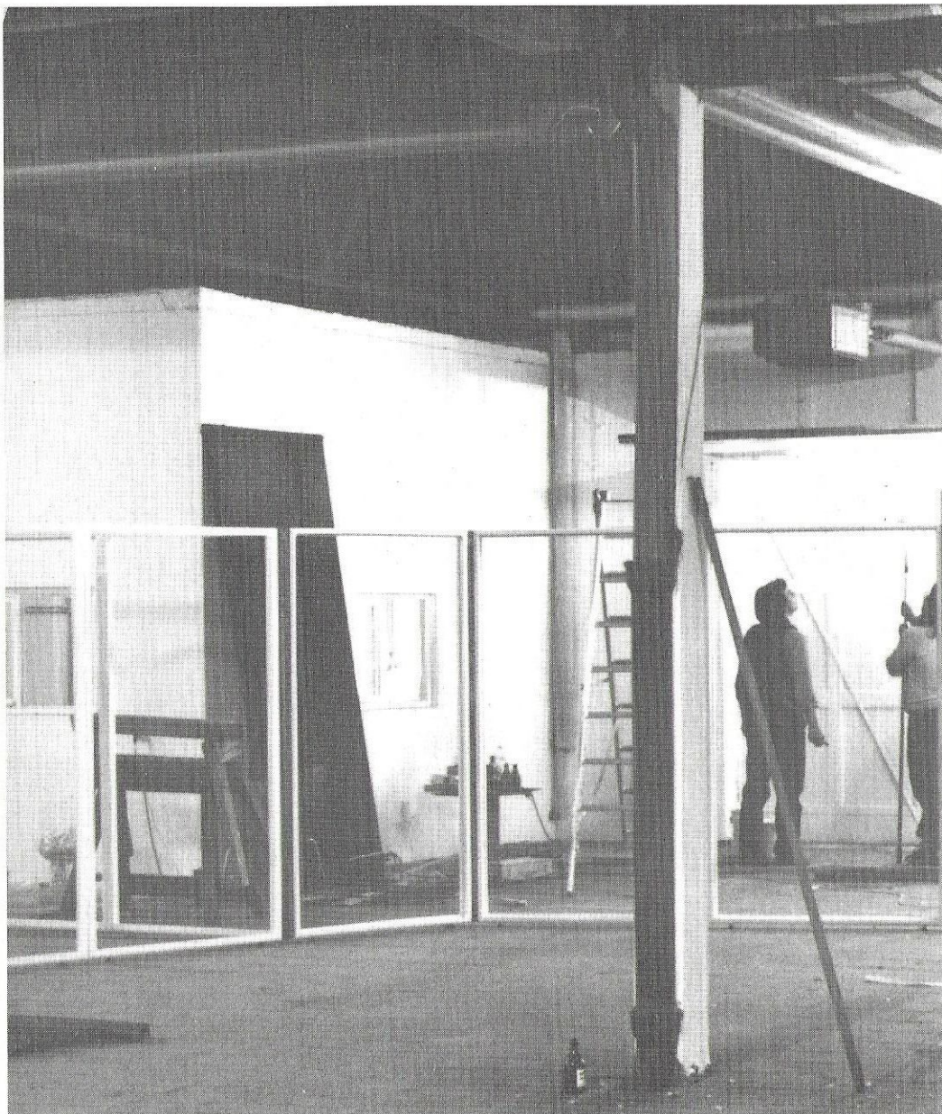
Umnutzung: Aufbau einer Ausstellung in der ehemaligen Warenannahme, 1992
