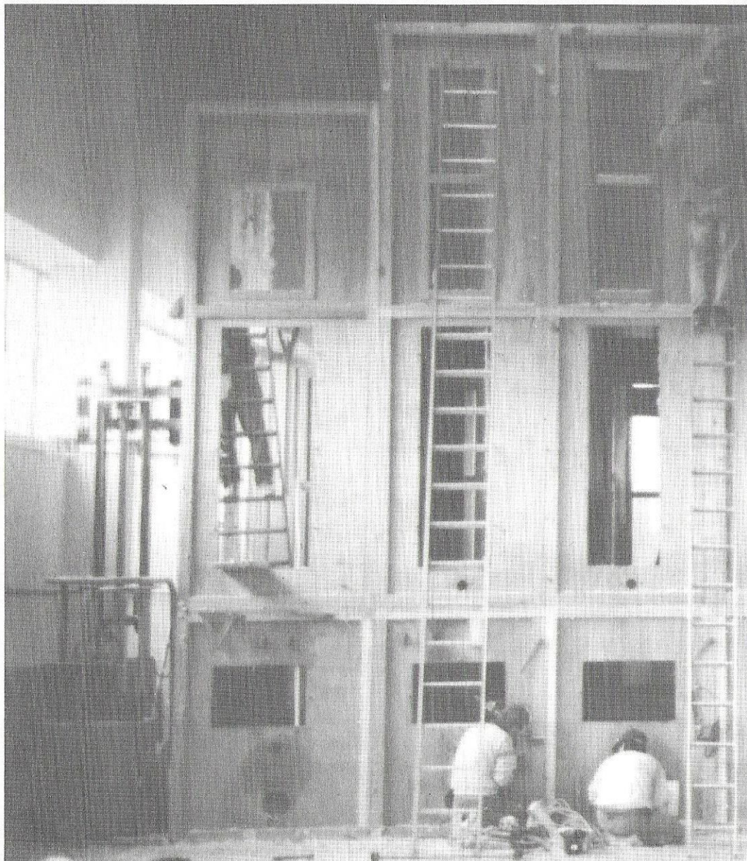
Abbau der Sortiermaschine in der 60er-Jahre-Halle von W&E für die Bettfedernproduktion in Ungarn. Ungarische Monteure bei der Arbeit, 1991.
