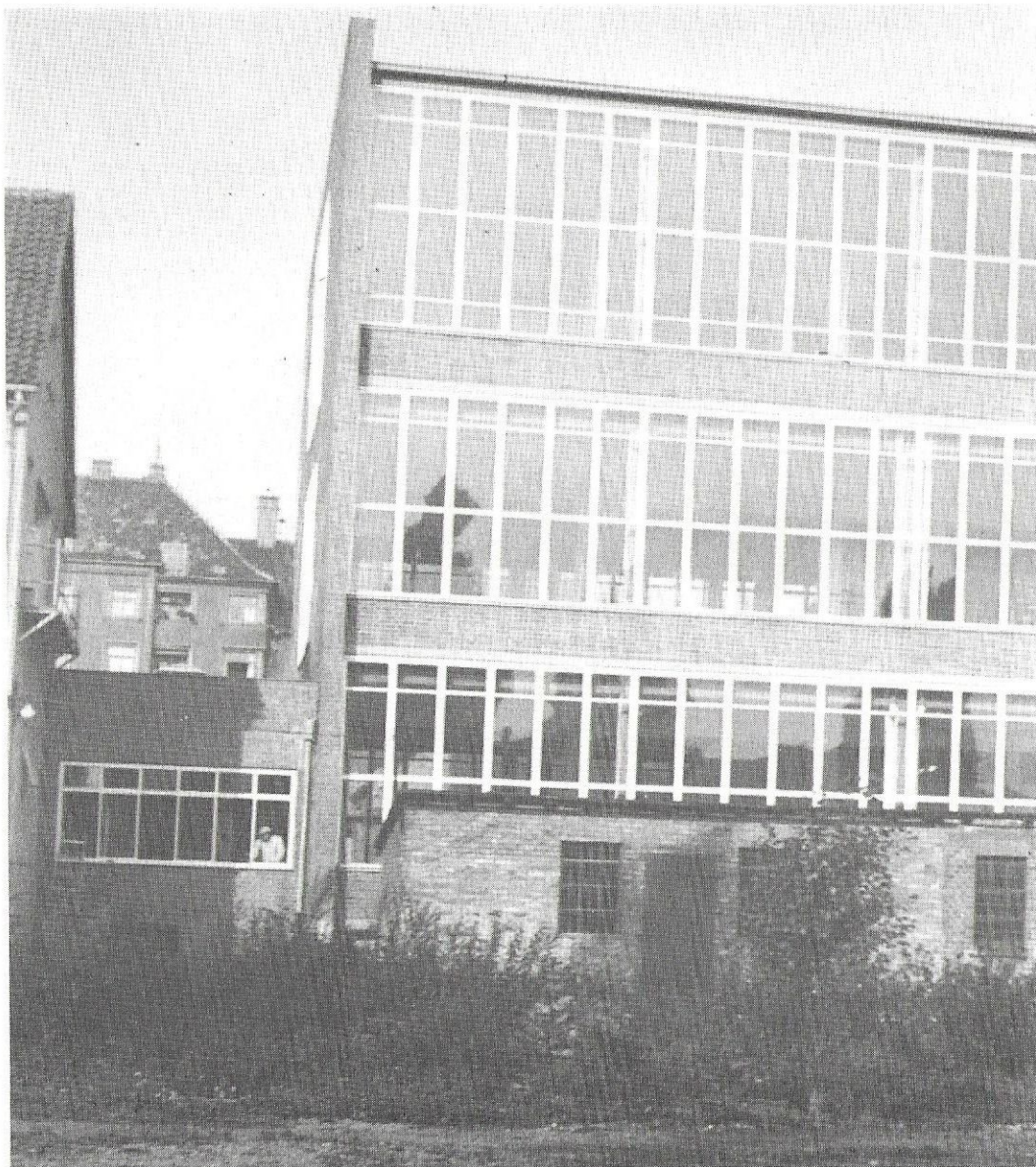
Zinsser-Halle: Mit der neuen Produktionshalle setzte sich W & E 1954 ein architektonisches Denkmal; die Glasflächen der Sichtfront mußten später mit Farbe getönt werden, weil die Temperaturen während der Sommerzeit im Gebäude unerträglich wurden.
